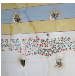
Le déshabillage des murs laisse apparaître des décorations d'un autre temps, ici au plafond du hall d'entrée.
